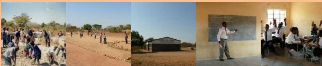
2005 – NRC začíná stavět školu. Nyní má škola dvě třídy, kancelář a sklad.
